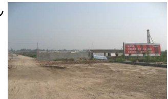
新工場建設中の様子
